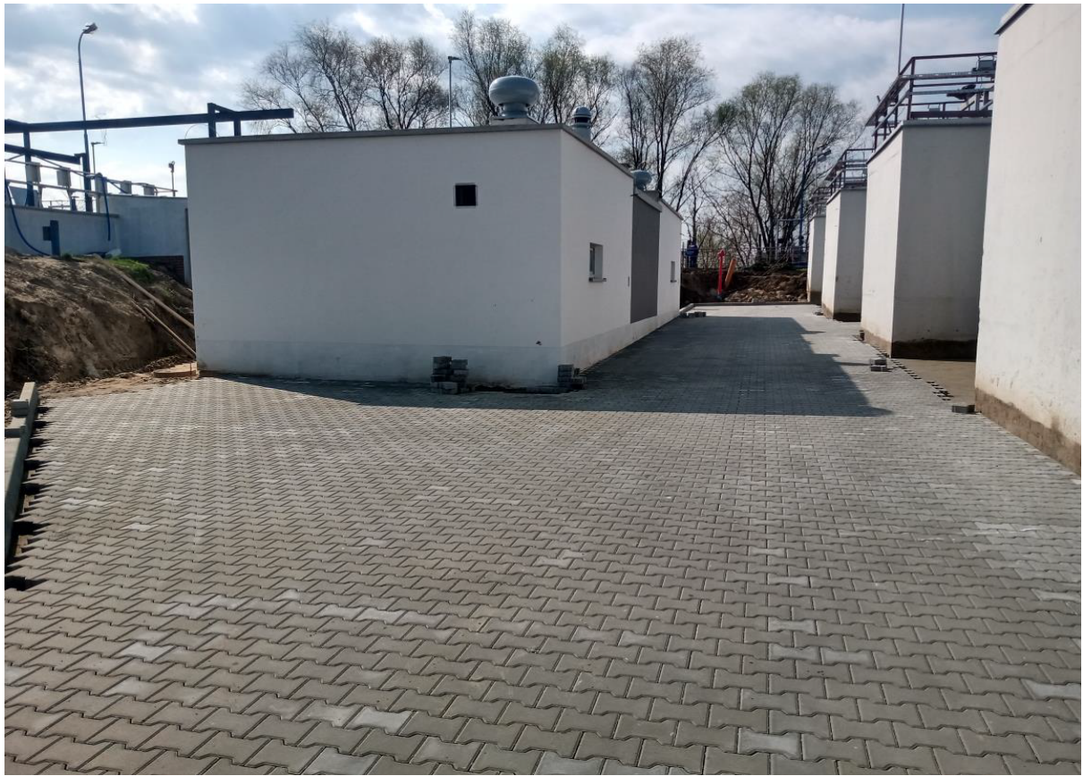
Ob. nr 7 Pompownia ścieków recykulowanych
