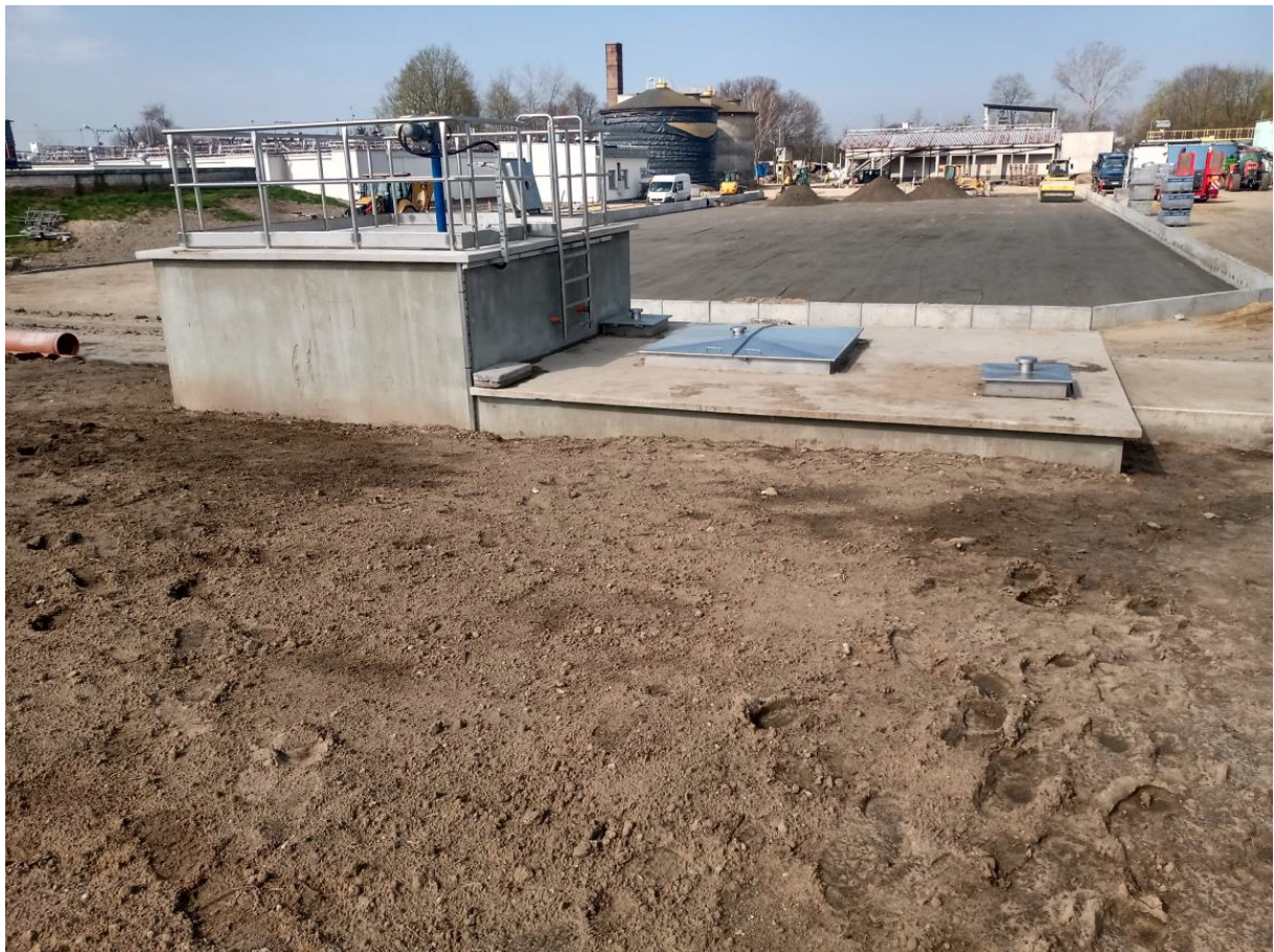
Ob. Nr 34 Pompownia wody technologicznej
