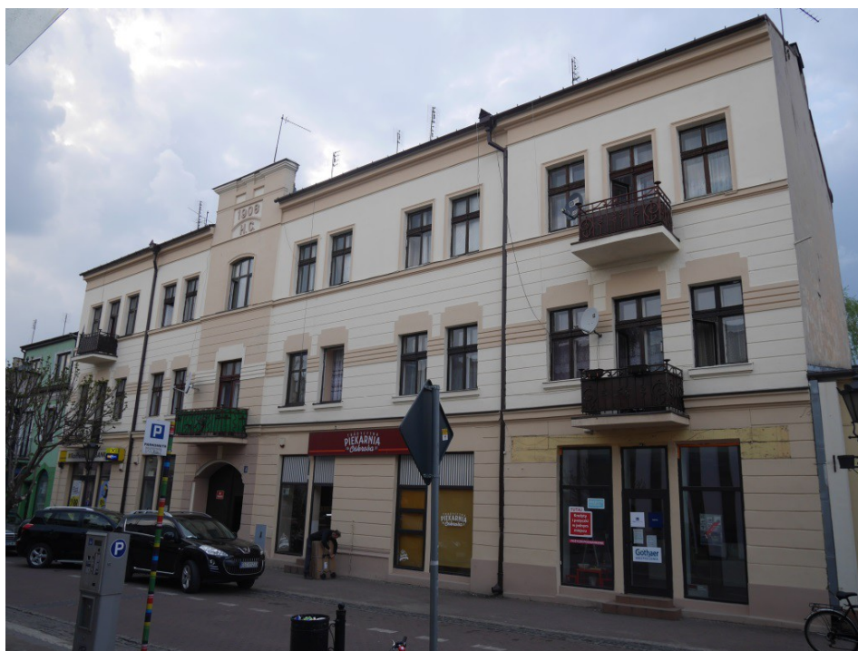
Fot. Odnowiona kamienica przy ul. Zduńskiej 2 w Łowiczu
